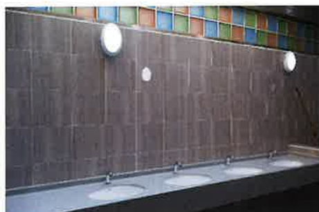
New Toilet Sinks
